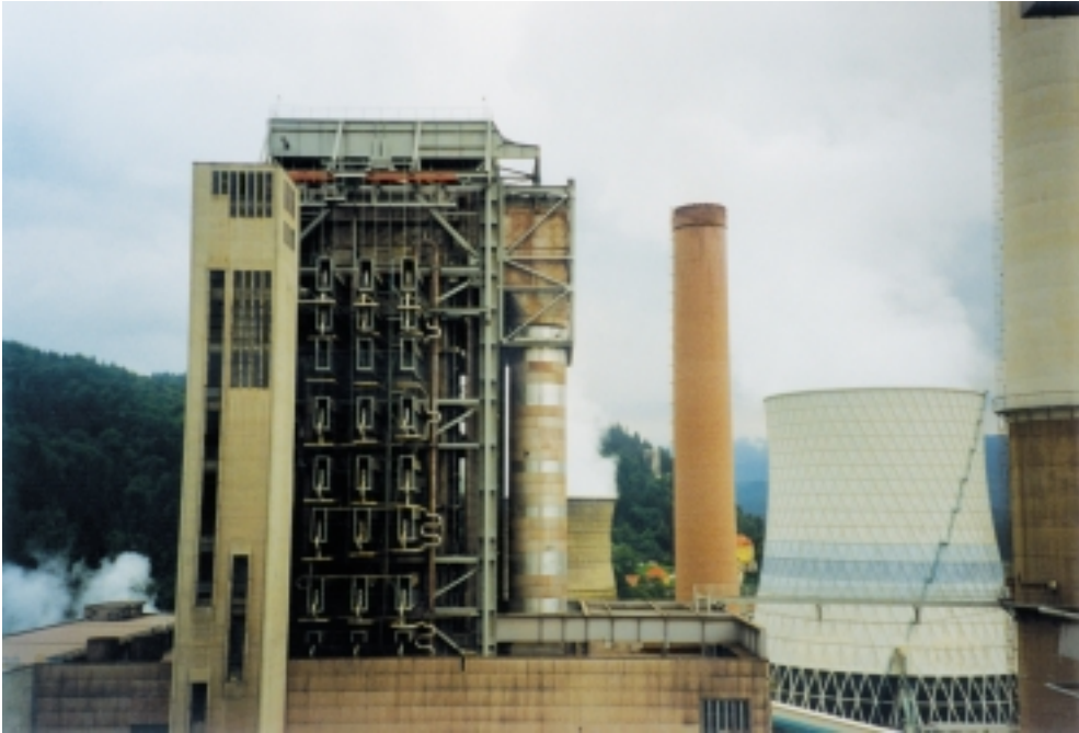
Kotel bloka IV v termoelektrarni Šoštanj je izpostavljen malocikličnemu utrujanju pri visokih temperaturah ter koroziji.
