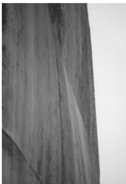
Slika 3: Lokalna deformacija plašča Figure 3: Local shell deviation
