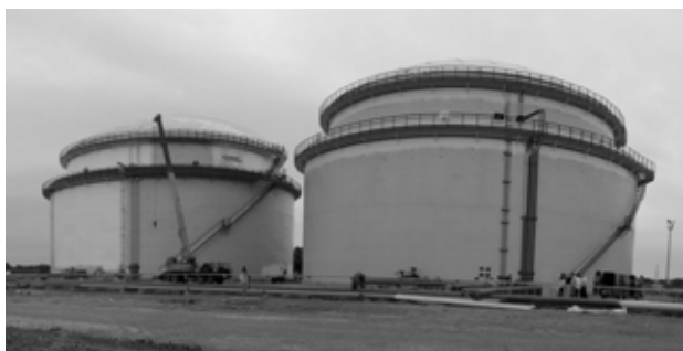
Slika 1: Nova rezervoarja za naftne derivate, zgrajena leta 2004 Figure 1: New above-ground storage tanks built in 2004
