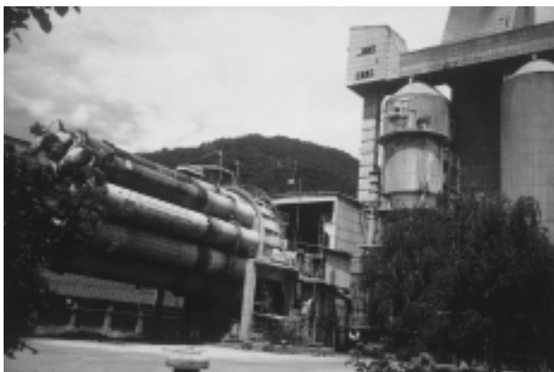
Slika 1: Rotacijska peč v cementarni Skale s kapaciteto 2000 t klinkerja na dan
