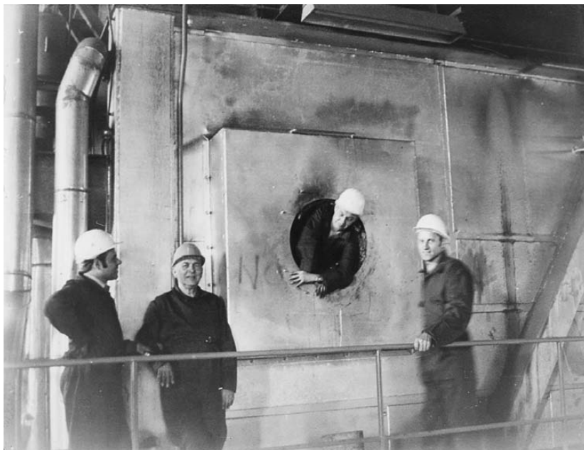
Slika 8: Na izhodu iz bobna parnega kotla v TE-TOL Ljubljana po pregledu notranje površine (drugi z leve: dipl. ing. B. Wolf, vodja laboratorija, kjer sem začel delo, desno vodja strojnega vzdrževanja v TE-TOL Ljubljana)
